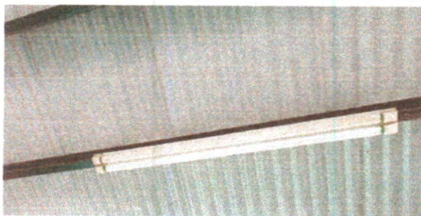
Sustitución lámparas por focos ahorradores y tomacorrientes dobles
