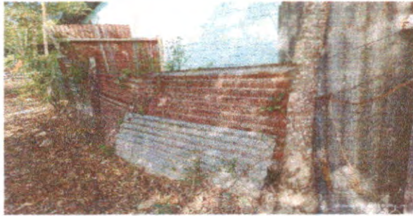
Foto 1 Sustrucción de malla en muro perimetral
