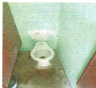
Sustitución de inodoro y lavamanos
