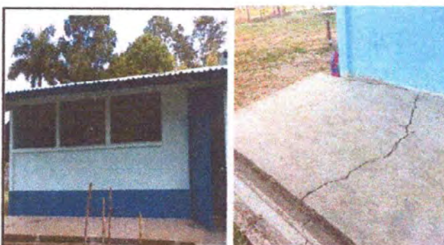
Foto 4: 9.1 Pintura en muros de exteriores e interiores 21.4 sellado de grietas y fisuras en muros.
