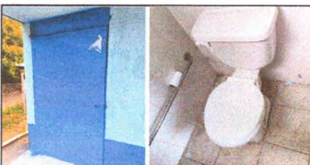
Foto 6: 10.3 Sustitución de inodoro 4.4 Sustitución de puerta de servicios sanitarios. 19.15 Instalación de inodoro
