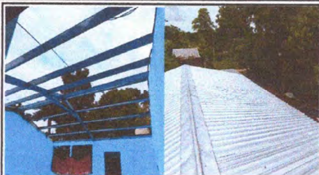
Foto1: 1.1 Sustitución de lámina, por lámina traquelada aluzinc calibre 26 legítimo. 2.1 Sustitución de estructura de soporte de metal, por metal. 19.8 Instalación de láminas troqueladas aluzinc
