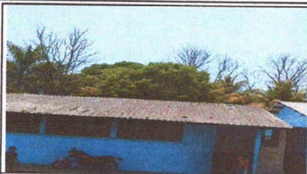
Foto 1: 1.1 Sustitución de lámina, por lámina traquelada aluzinc calibre 26 legítimo. 2.1 Sustitución de estructura de soporte de metal, por metal. 19.8 Instalación de láminas troqueladas aluzinc
