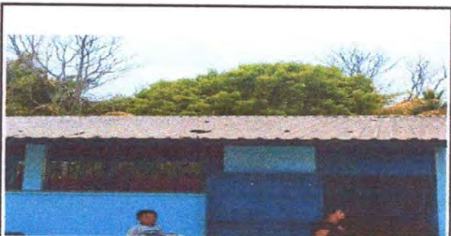
Foto 5: 19.1 desinstalación de estructura portante de metal
