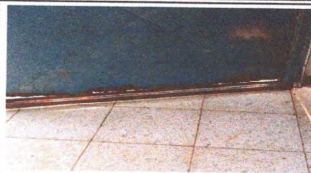
Foto 2: 4.1 Mantenimiento a estructuras de puertas de metal 4.3 sustitución de puerta metal en módulo
