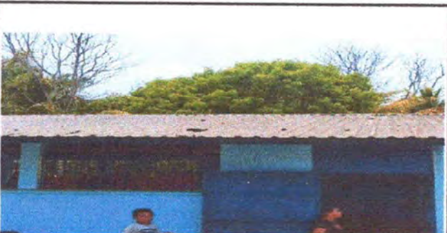
Foto 5: 19.1 desinstalación de estructura portante de metal
