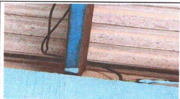
Foto 3: 17.8 Sustitución de tomacorrientes dobles 17.12 sustitución de ducto eléctrico + accesorios 19.11 Instalación de unidades de luz (incluye interruptor, ducto y cable eléctrico)
