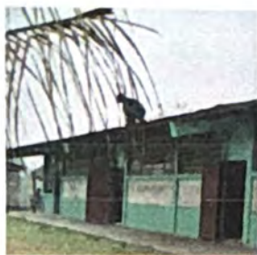
Foto 1: INSTALACION ESTRCUTURA METALICA Y LAMINA
