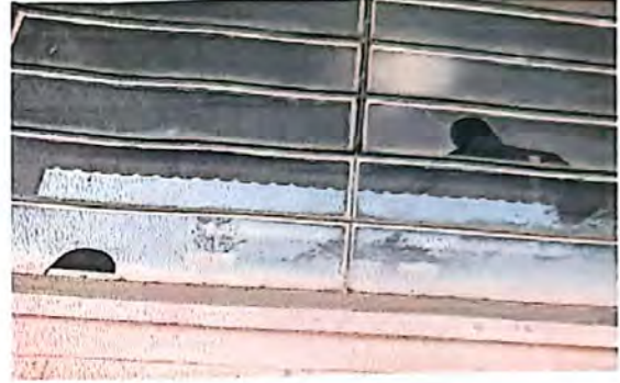
foto4 5.5 sustitucion de vidrio
