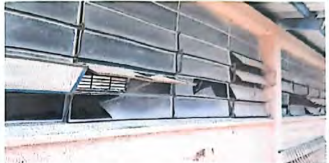
foto 2. 5.5 sustitucion de vidrio
