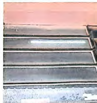
foto 4 5.5 sustitucion de vidrio
