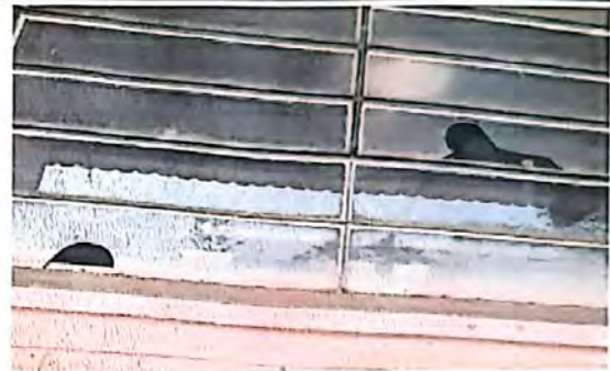
foto 4 5.5 sustitucion de vidrio
