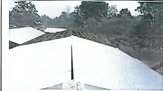
foto1 1.1 sustitucion de lamina, por lamina troquelada aluzinc calibre 26
