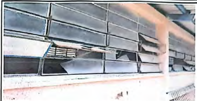
foto 2. 5.5 sustitucion de vidrio
