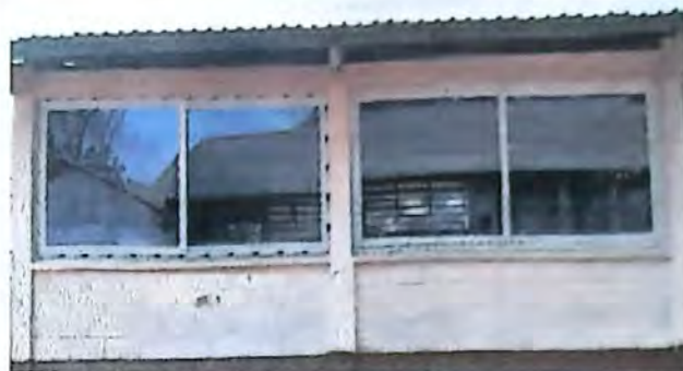
foto 2. 5.5 sustitucion de vidrio
