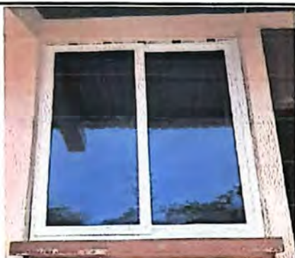
foto 3. 5.5 sustitucion de vidrio
