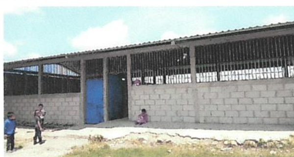
Foto 2: Sustitución de piso cemento líquido
