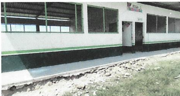
Foto 1: Sustitución de ventanas estructuras metálica
