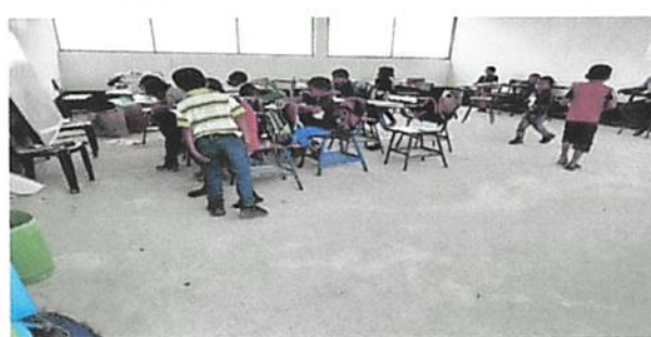
Foto 4: Sustitución de piso cemento líquido
