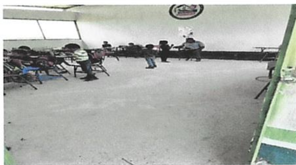
Foto 3: Sustitución de piso cemento líquido
