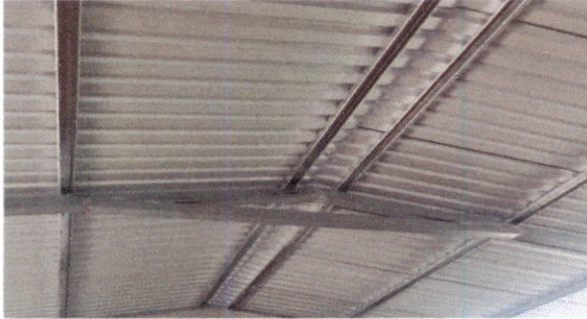
FOTO. 1 SUSTITUCION DE LAMINA TROQUELADA ALUMINIO CALIBRE 26
