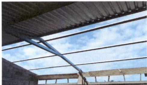
Foto1: SUSTITUCION DE LAMINA TROQUELADA ALUMINIO CALIBRE 26
