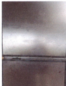
FOTO . 2 SUSTITUCION DE PUERTAS
