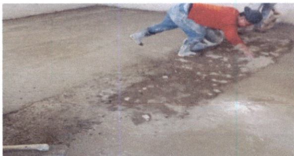
FOTO . 3. SUSTITUCION DE PISO DE CEMENTO LIQUIDO
