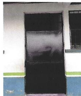
Foto 4: Aula 3. Sustitución de puerta.
