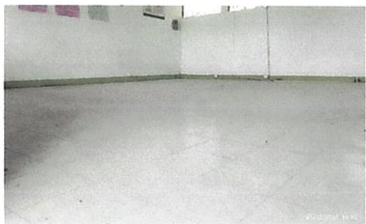
Foto1: Aula 1. Sustitución de piso cerámico.
