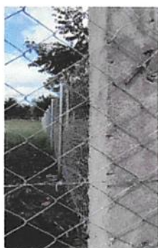
Foto 3: Perímetro. Reparación de tubo hg y malla galvanizada.
