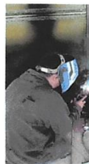
Foto 4: Aula 3. Sustitución de puerta.
