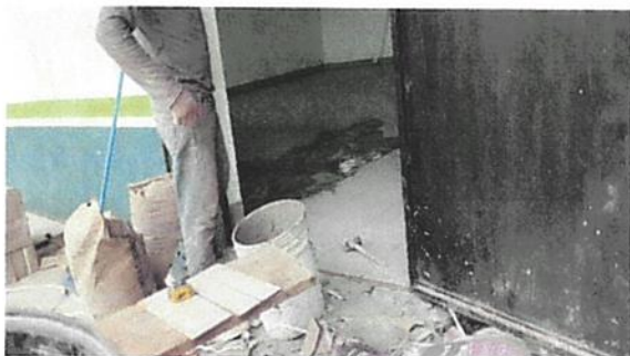
Foto1: Aula 1. Sustitución de piso cerámico.
