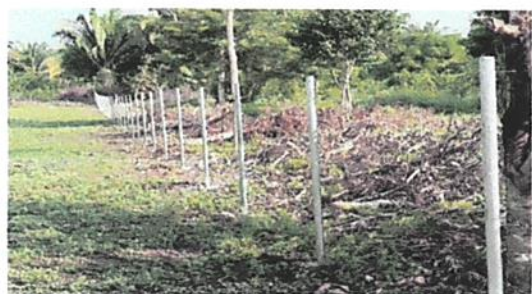
Foto 3: Perímetro. Reparación de tubo hg y malla galvanizada.
