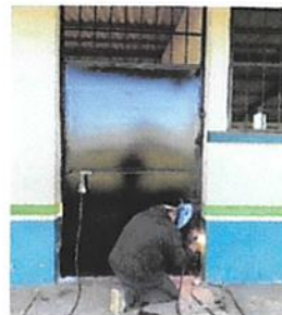
Foto 2: Aula 2. Sustitución de puerta.
