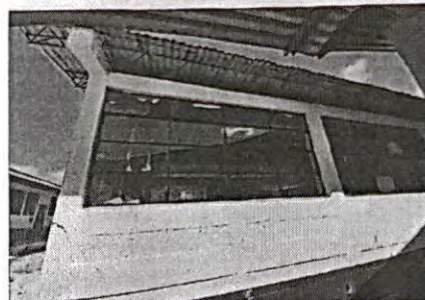
Foto 2: Cambio de Persianas por Balcones
