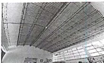
Foto 3: Sustitucion de techo de lamina rustica por Lamina Troquelada
