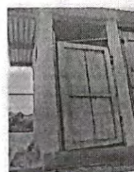
Foto 6: Sustitucion de Puertas de madera rustica por Puertas de metal
