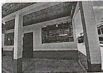
Foto 8: Cambio de pintura en fachada actual por Pintura de Aceite
