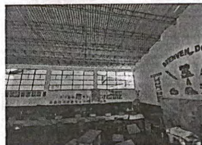
Foto 4: Sustitucion de estructura metalica por Costaneras galvanizas troqueladas
