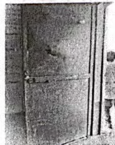
Foto 2: Sustitución de puerta
