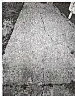
Foto 4: reparación de piso
