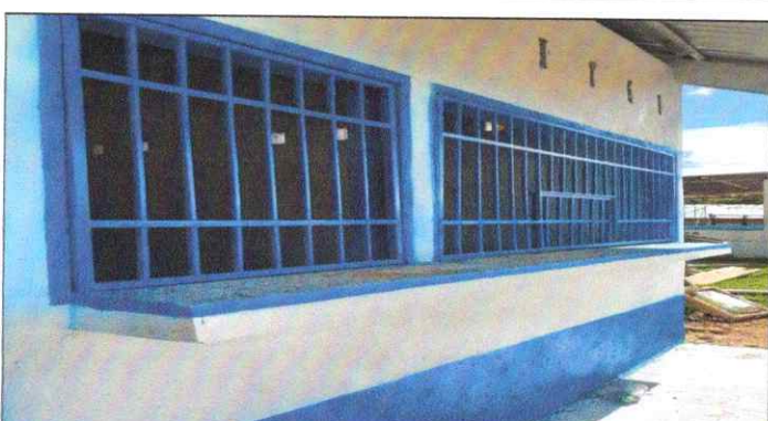
Foto 4: Fabricación e instalación de ventana-balcon de metal
