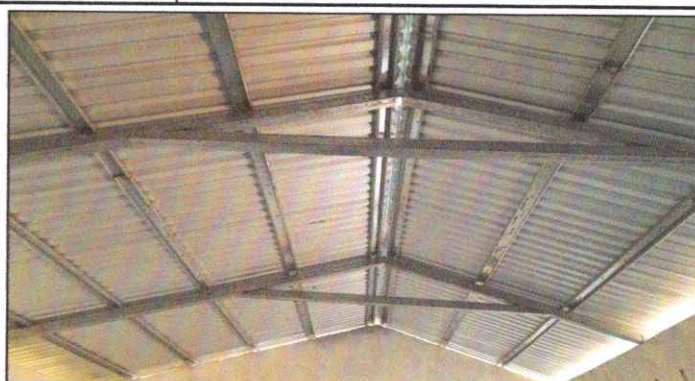
Foto 2: Instalación de lámina troquelada aluzinc / Sustitución de estructura de soporte de metal, por metal
