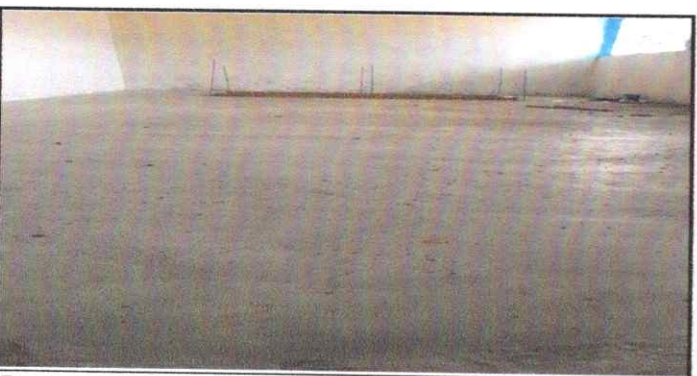
Foto 5: Sustitución de piso de cemento líquido
