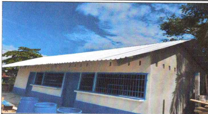
Foto1: Repello en muro /Pintura en muros exteriores e interiores
