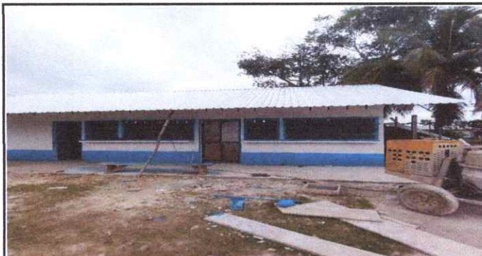
Foto 2: Instalación de lámina troquelada aluzinc / Sustitución de estructura de soporte de metal, por metal
