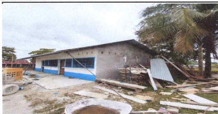
Foto1: Repello en muro /Pintura en muros exteriores e interiores
