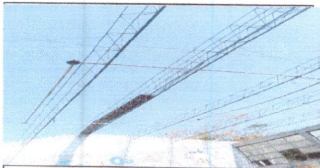
foto 5 sustitucion de cableado para energia electrica
