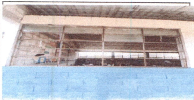
foto 3 sustitucion de ventana de balcon
