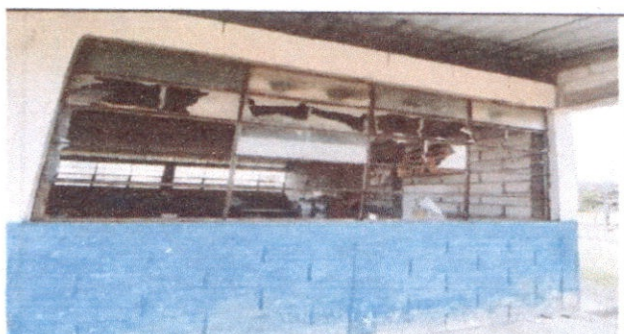
foto 4 pintura para muro
