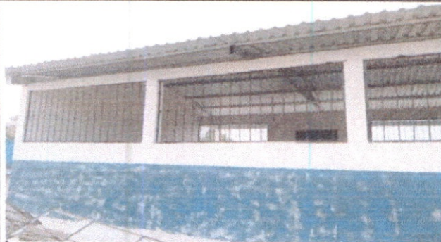
foto 1 cambio de techado
