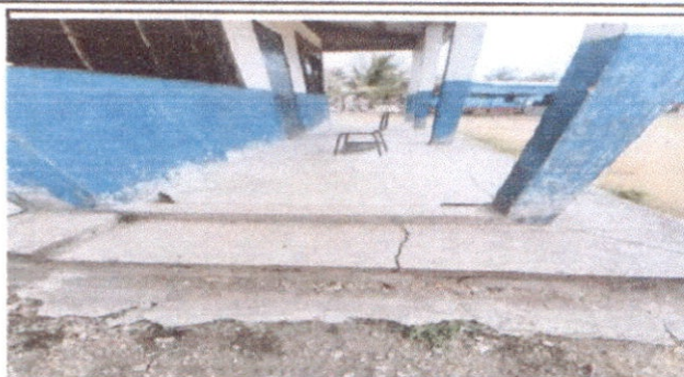
foto 2 repello de cemento para muro
