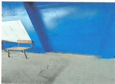
Foto 1: puerta de metal
