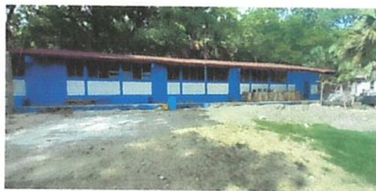
Foto 5: pintura en muro
