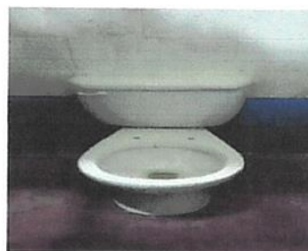
Foto 6: reparacion de baños
