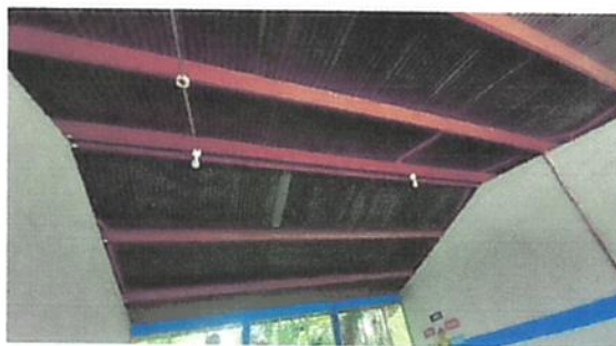
Foto 4: reparacion del sistema Electrico
