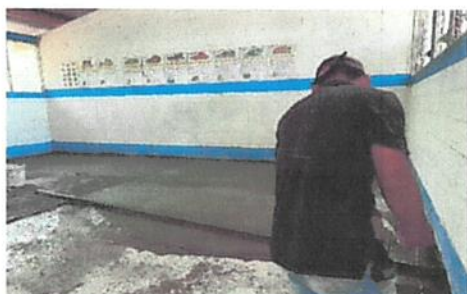
Foto 3: reparacion de piso
