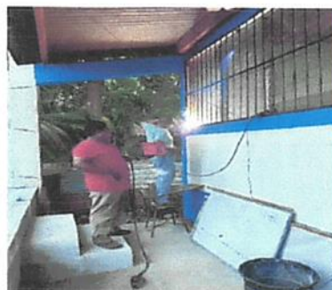
Foto 2: sustitucion de balcones.
