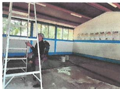
Foto 4: reparacion del sistema Electrico
