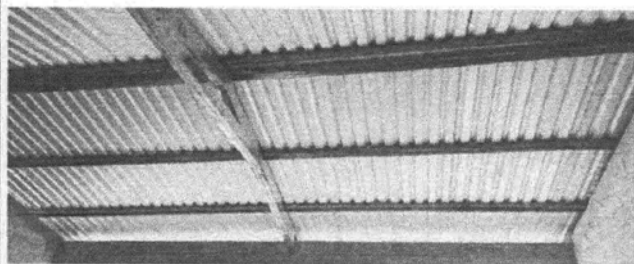
Foto 1: Sustitución de Cubierta de lámina
