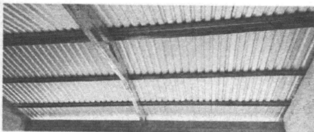
Foto 1: Sustrucción de Cubierta de lámina
