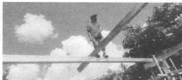
Foto 2: Estructura de Techo
