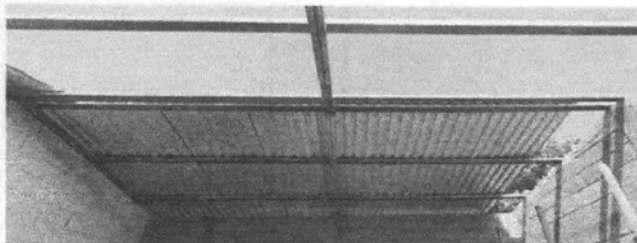
Foto1: Cubierta de lámina
