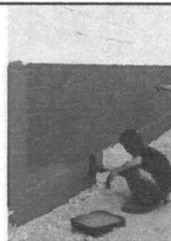
Foto 6: Pintura de muros exteriores e interiores
