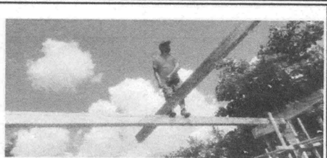
Foto 2: Estructura de Techo
