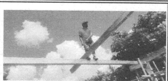
Foto 2: Estructura de Techo
