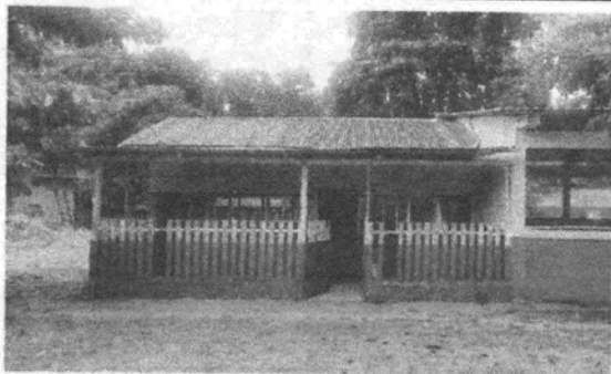
Foto1: Cubierta de lámina
