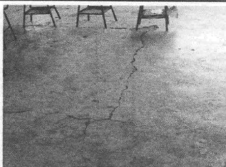
Foto 5: Reparación de piso de cemento
