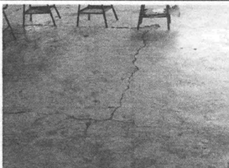
Foto 5: Reparación de piso de cemento
