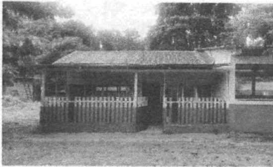
Foto1: Cubierta de lámina
