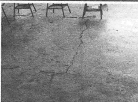
Foto 5: Reparación de piso de cemento
