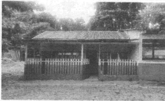
Foto1: Cubierta de lámina
