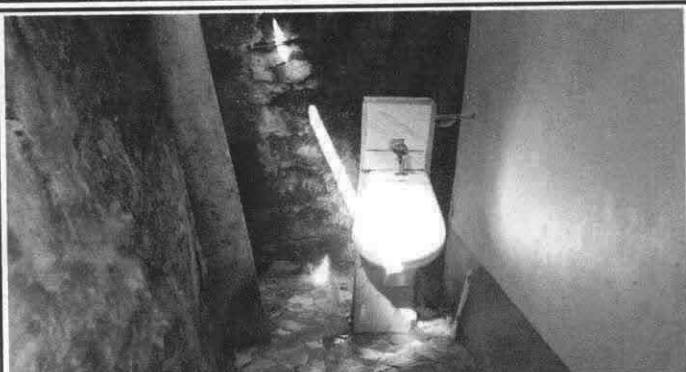
Foto 7: Sustrucción de migitorio.
