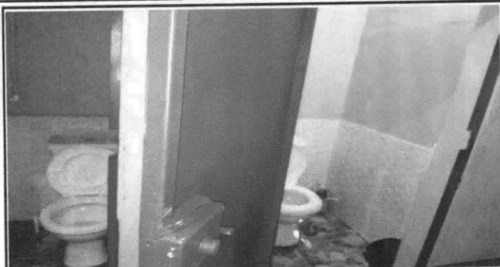
Foto 2: Sustitución de inodoros.
