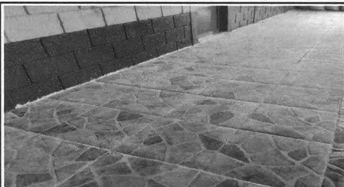
Foto 13: Sustitución de piso de cerámica.
