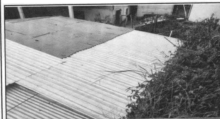
Foto 5: Sustitución de estructura de soporte de madera, por metal y sustitución de lámina, por lámina troquelada aluzinc calibre 26.
