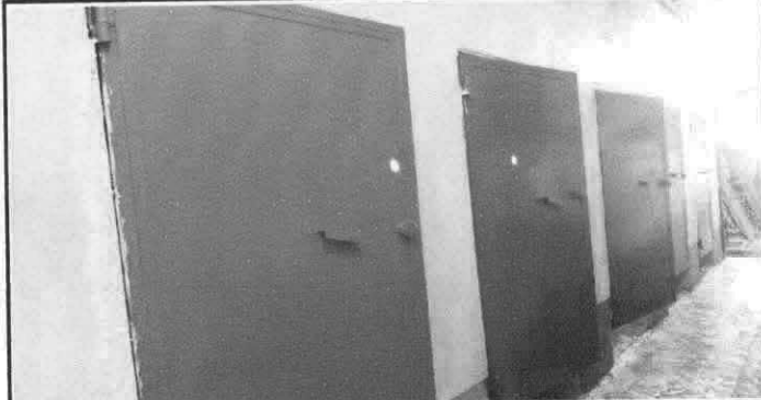
Foto 8: Sustrucción de puertas en servicios sanitarios.
