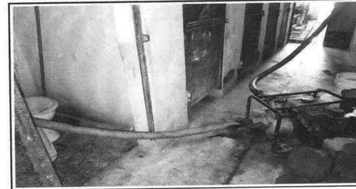
Foto 12: Limpieza de fosa séptica.
