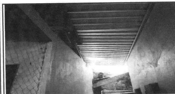
Foto 11: Sustrucción de ducto eléctrico + accesorios.
