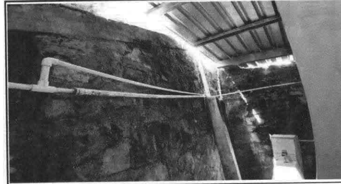
Foto 10: Sustrucción de tubería línea principal.
