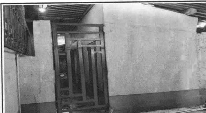
Foto 9: Sustrucción de puerta de rejas.
