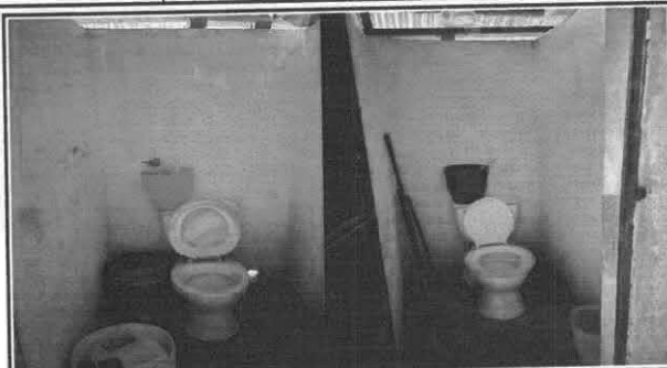
Foto 2: Sustitución de inodoros.
