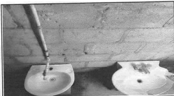
Foto 3: Sustitución de tres lavamanos.
