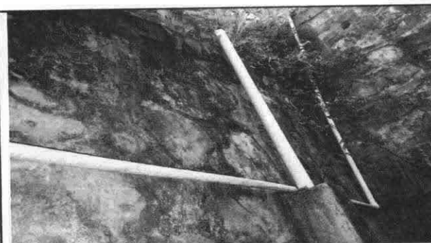
Foto 10: Sustruir tubería línea principal.
