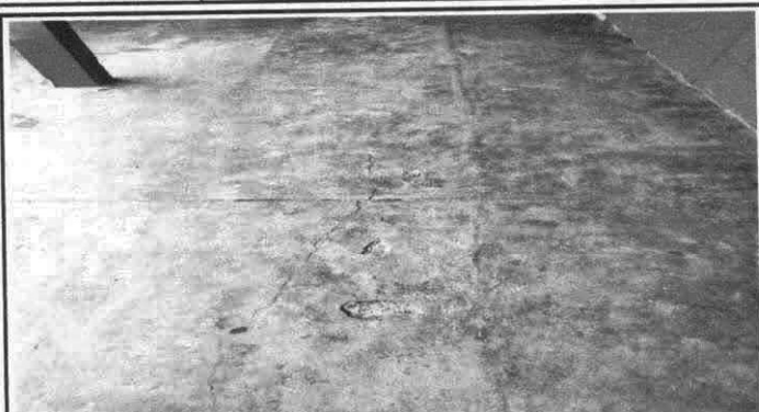
Foto 13: Sustitución de piso cerámico.
