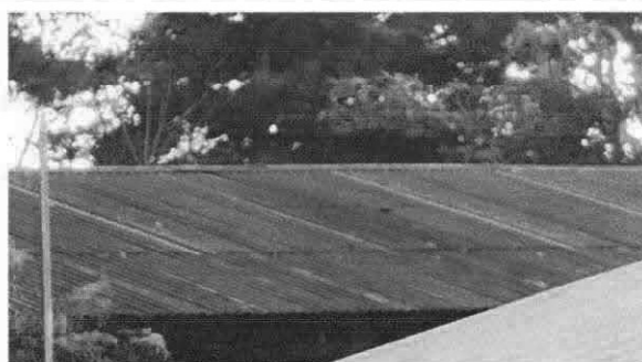
Foto 8: Sustitución de lámina por lámina troquelada
