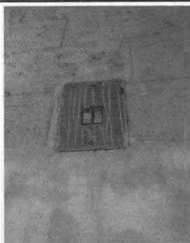
Foto 13: Sustitución de Filipon y tablero
