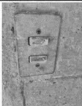
Foto 11: Sustitución de interruptores dobles
