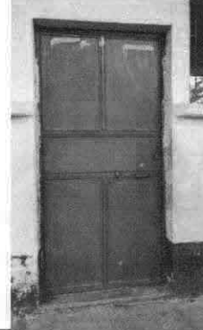
Foto 2: Mantenimiento a estructura lijado, cepillado y aplicación de pintura.
