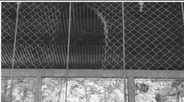
Foto 5: Sustitución de estructura de metal de ventana.
