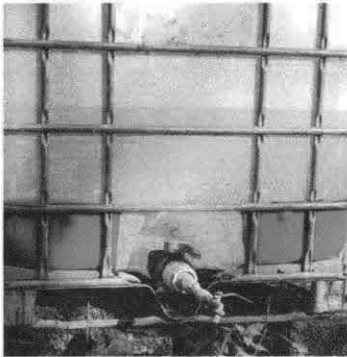
Foto 1: Sustitución de deposito de Agua 1000 lt
