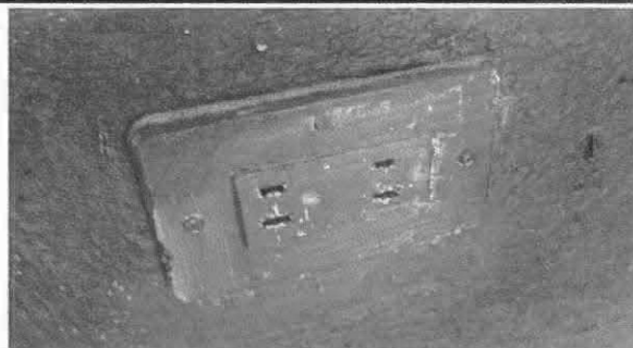
Foto 12: Sustitución de tomacorrientes dobles
