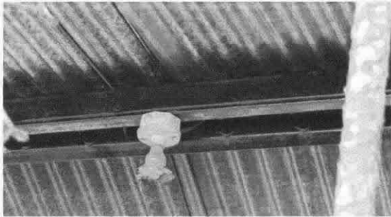
Foto 3: Sustitución de lamparas tipo LED:
