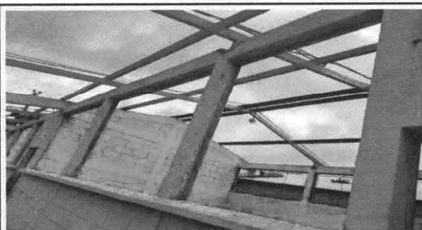
Foto 3: Aulas total 3 sustitución de balcones de metal.
