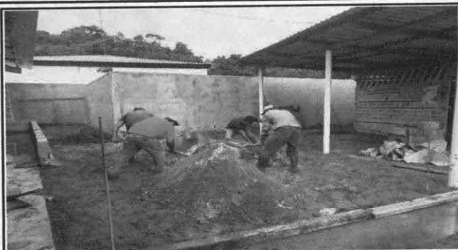
Foto7: Sustitución de piso de torta de concreto.
