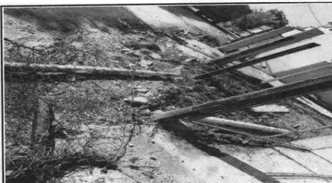
Foto 10: Sustitución de malla galvanizada.
