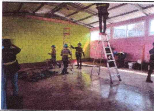
Foto1: Instalación de luz
