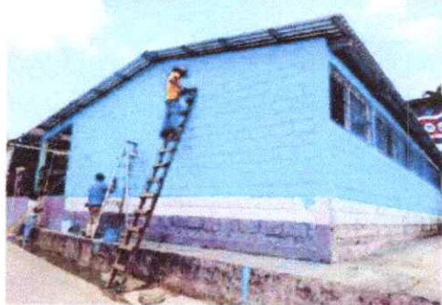
Foto1: Pintura de muros exteriores e interiores
