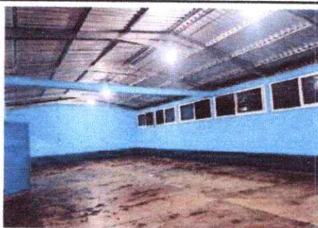
Foto 5: Pintura de muros exteriores e interiores
