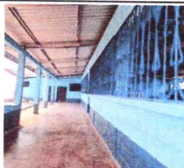
Foto 4: Pintura de muros exteriores e interiores
