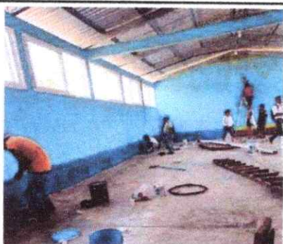
Foto 3: Pintura de muros exteriores e interiores
