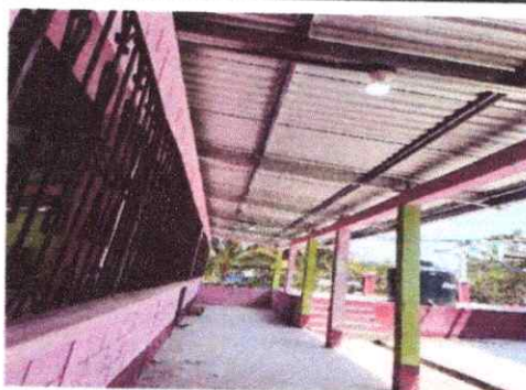
Foto 4: Instalación de luz
