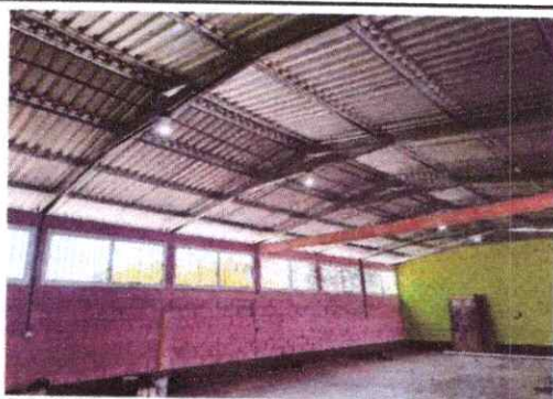
Foto 3: Instalación de luz
