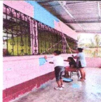
Foto 2: Pintura de muros exteriores e interiores
