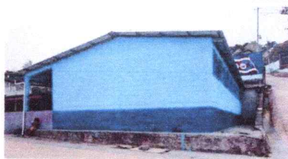
Foto 6: Pintura de muros exteriores e interiores
