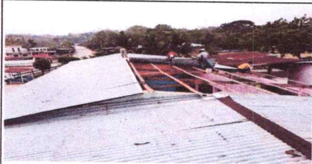
Foto1: Sustitución de estructura de madera, por estructura metalica y laminas.
