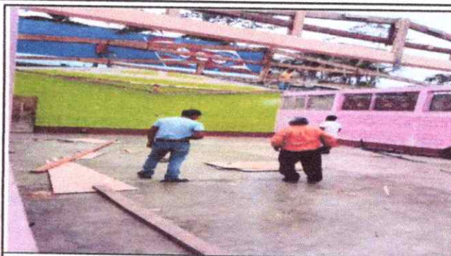
Foto 2: Sustitución de estructura de madera, por estructura metalica y laminas.
