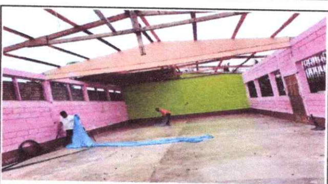
Foto 4: Sustitución de estructura de madera, por estructura metalica y laminas.
