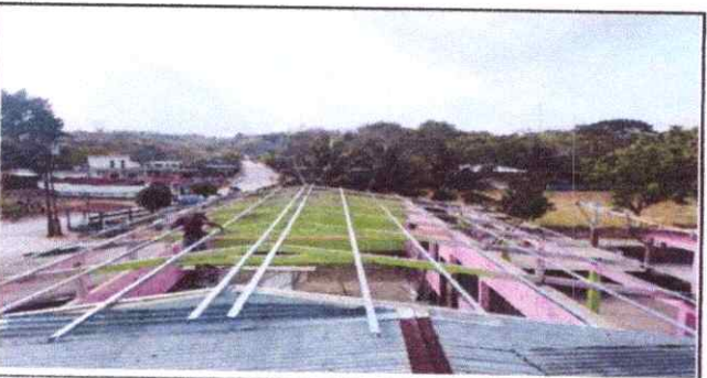
Foto 5: Sustitución de estructura de madera, por estructura metalica y laminas.
