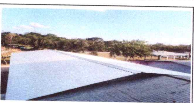
Foto 6: Sustitución de estructura de madera, por estructura metalica y laminas.
