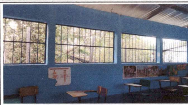
Foto 2: BALCONES INSTALADOS EN MODULO 2
