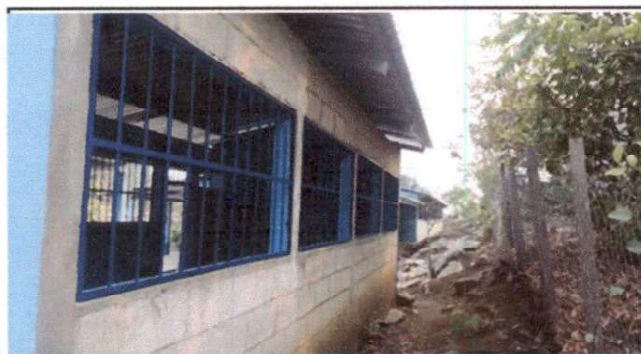
Foto 3: BALCONES INSTALADOS EN LA PARTE DE ATRÁS MODULO 1
