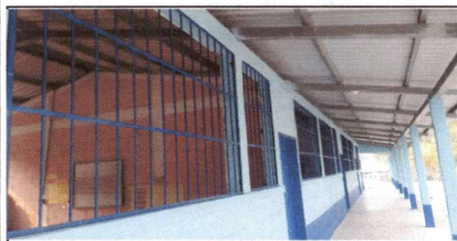
Foto 5: BALCONES INSTALADOS EN MODULOS
