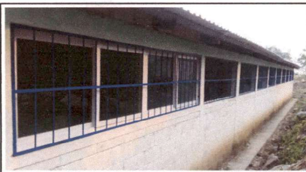
Foto 4: SUSTITUCION DE BALCONES EN LA PARTE DE ATRÁS MODULO 2
