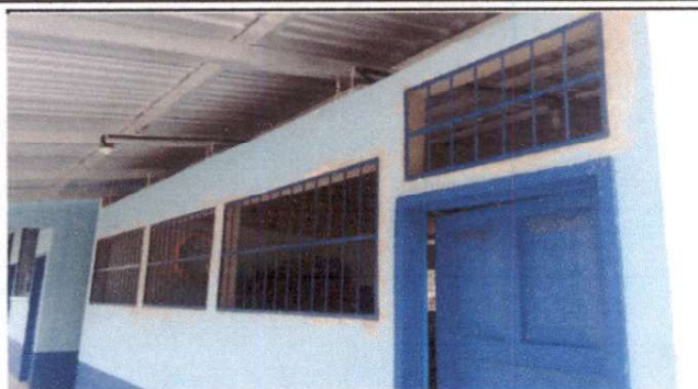
Foto1: BALCONES INSTALADOS EN MODULO 1
