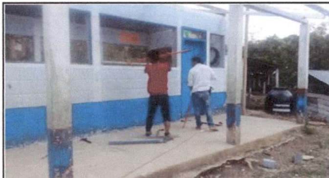
Foto 4: DESMONTAJE DE MALLA EN VENTANAS
