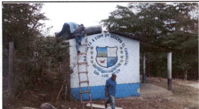
Foto1: DESMONTAJE DE LAMINA EXISTENTE
