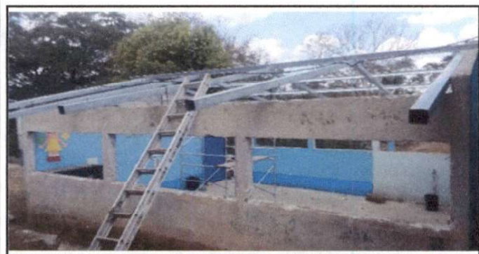
Foto 5: INSTALACION DE ESTRUCTURA PORLANTE DE METAL
