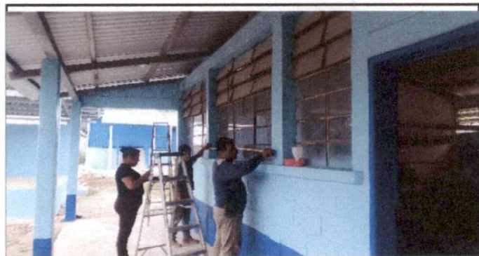
Foto 3: DESMONTAJE DE BALCONES
