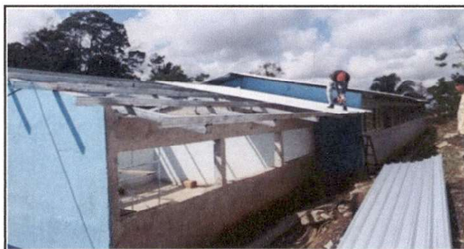
Foto 6: INSTALACION DE LAMINA ALUZIN CALIBRE 26
