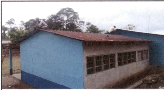
Foto 2: DESMONTAJE DE LAMINA EXISTENTE SEGUNDA AULA
