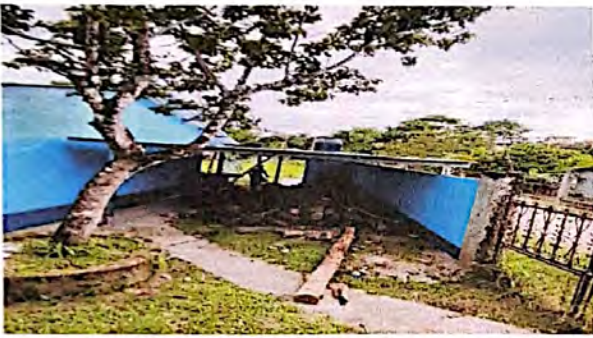
Foto1: Reparación de muro perimetral de block.
