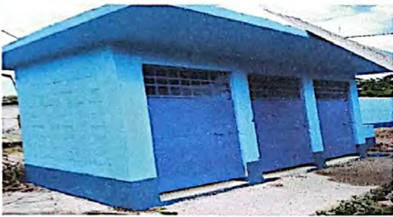
Foto1: Sustitución de servicios sanitarios.
