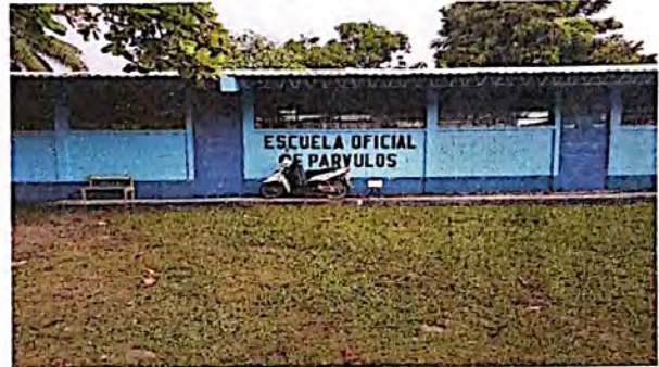
Foto 2: Sustitución de lámina por laminá troquelada calibre 26
