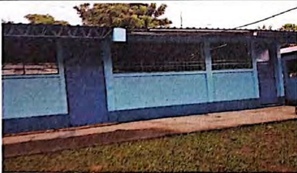
Foto 5: Sustitución de puerta y sustitución de chiapa.
