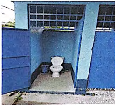
Foto 3: Sustitución de servicios de sanitarios.
