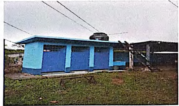
Foto 2: Sustitución de puertas en servicios sanitarios.
