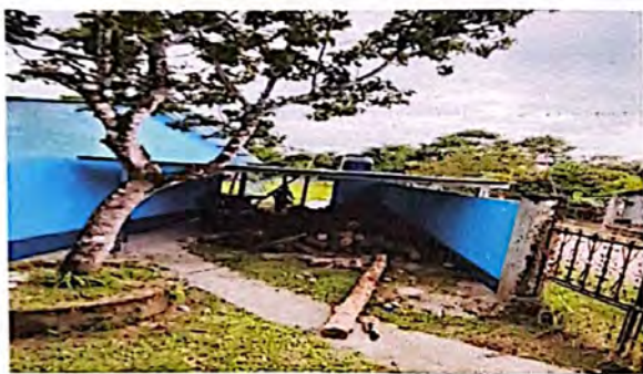
Foto 1: Reparación de muro perimetral de block.
