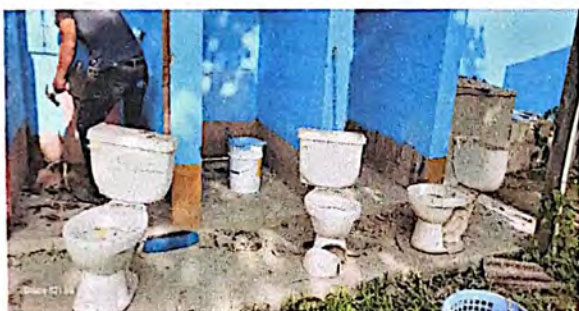
Foto1: Sustritución de servicios sanitarios.
