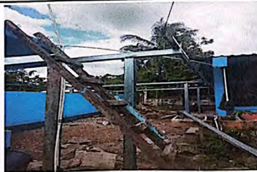
Foto 2: Sustitución de lámina por laminá troquelada calibre 26
