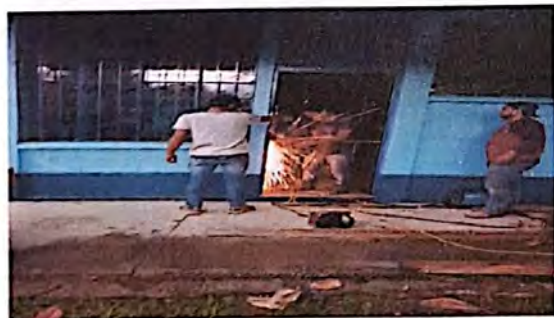
Foto 5: Sustitución de puerta y sustitución de chiapa.
