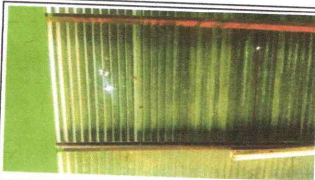
Foto 2: Sustrucion de lamina por lamina troquelada
