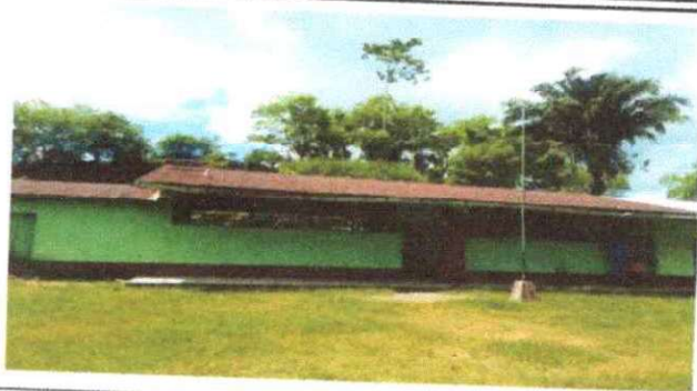
Foto 1: Sustrución de lamina por lamina troquelada
