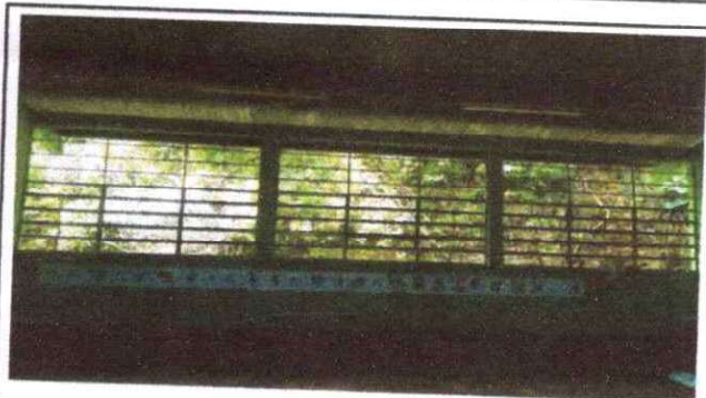
Foto 3: Sustrucion de Balcones
