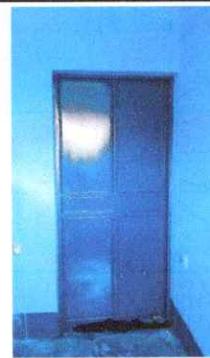
Foto 12: Instación de puerta de aula.
