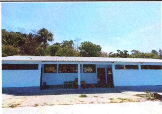
Foto 1: Finalización de pintura de exteriores e interiores.
