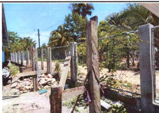
Foto 9: Finalización de los muros perimetrales .
