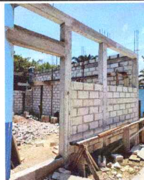
Foto 2: Construcción de aula (pendiente de finalización por falta de fondos).
