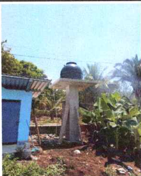
Foto 5: Finalización de base para rotoplas.
