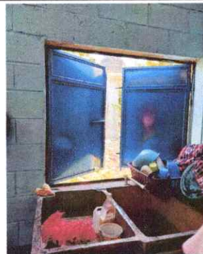
Foto 8: Finalización de instalación de ventana.
