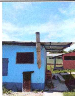
Foto 10: Finalización de chimenea de cocina.
