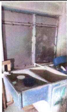
Foto 7: Instalación de ventana metálica.
