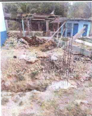
Foto1: Construcción de un aula
