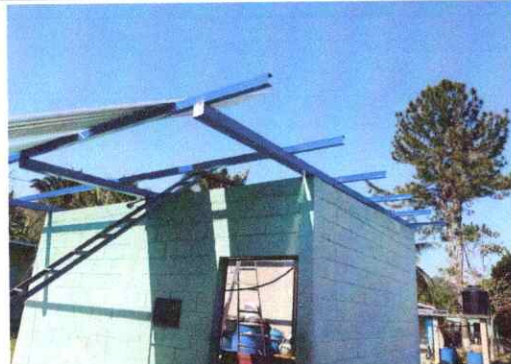
Foto 2: Reparación de techo de cocina.
