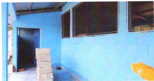
Foto 5: Reparación de balcones.
