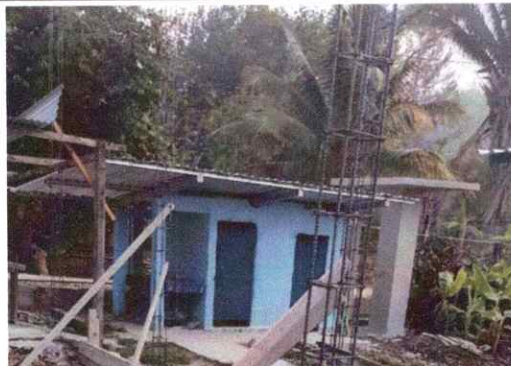
Foto 10: Reparación de baño y construcción de base para rotoplas.
