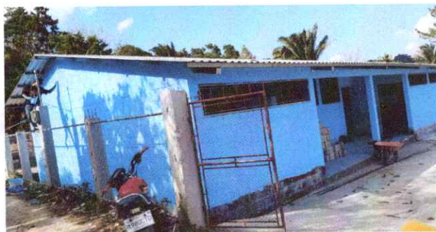
Foto 3: Construcción de muro perimetral.
