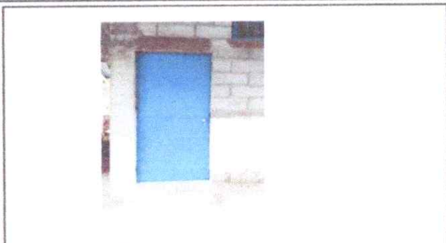
Foto1: SUSTITUCIÓN DE PUERTAS
