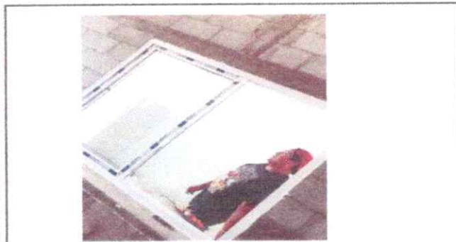
Foto 3: SUSTITUCION DE VENTANA
