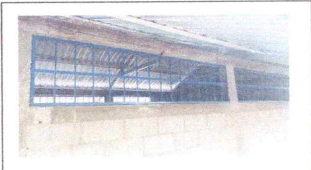
Foto 2: SUSTITUCIÓN EN BALCONES
