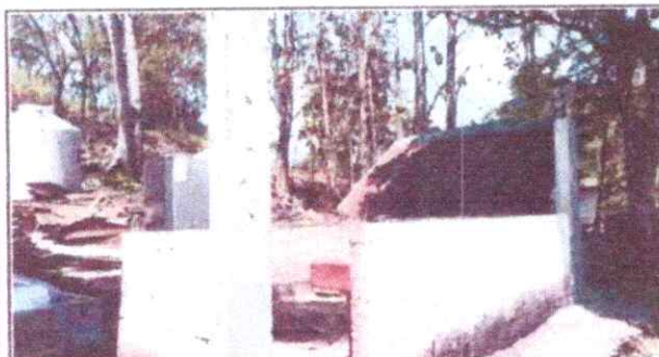
Foto 3: DESMONTAJE DE COCINA
