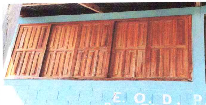
Foto 4: VENTANAS EN LA PARTE FRONTAL
