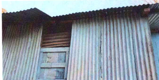
Foto 2: PUERTA Y VENTANA LEVANTADO DE BLOCK
