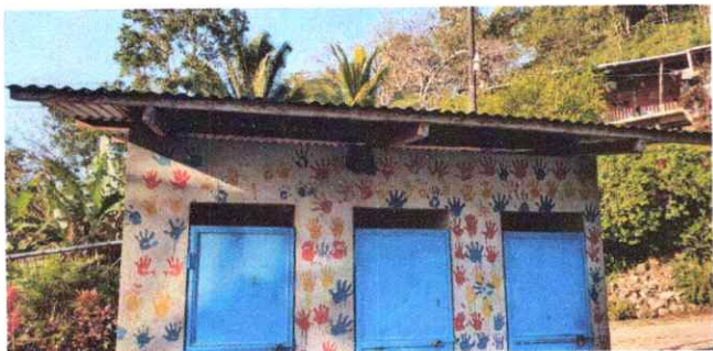
Foto1: REPARACION DE SANITARIOS,TECHO Y PUERTAS
