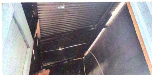
Foto 3: TECHO Y COCINA
