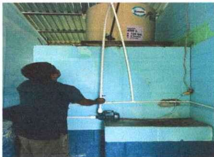
Foto 1: Sustitución de bomba
