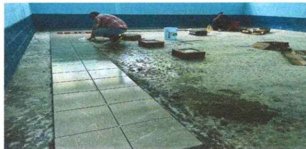
Foto 2: Instalación de piso ceramica
