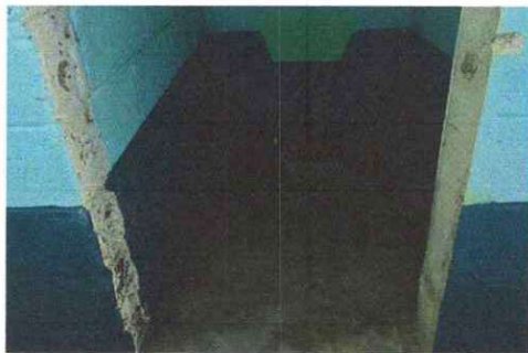
Foto 5: Sustitución de inodoros
