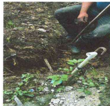
Foto 6: Sustitución de trubería pvc línea principal
