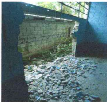
Foto 3: Fabricación de columna.
