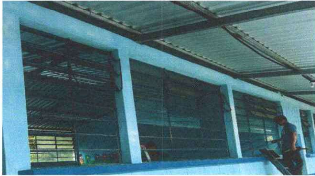
Foto 1 Mantenimiento a balcones
