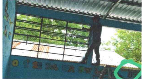
Foto 2: instalacion y fabricación de ventanas pvc
