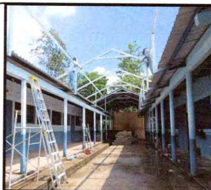
Foto 4: Instalación de estructura portante de metal en corredor
