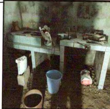
Foto 14: Instalación de azulejo a cocina rural
