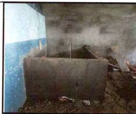
Foto 12: Instalación de pila y 1 lavadero en cocina
