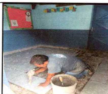
Foto 6: Sustitución de torta de piso de concreto por cerámica en dirección
