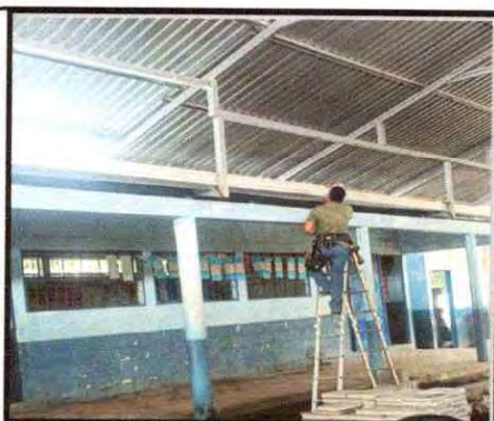
Foto 3: Sustitución de canal de PVC por canal de metal
