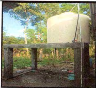
Foto 17: Instalación de depósito de agua de 2,500 lts para cocina
