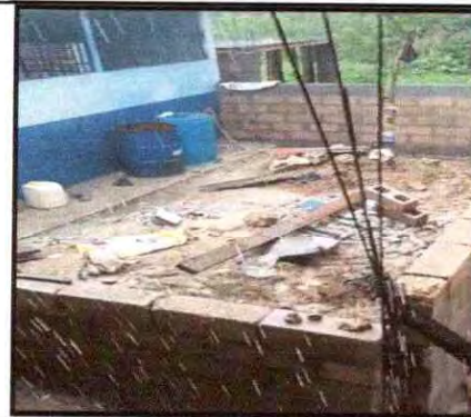
Foto 8: levantado de block en paredes de cocina
