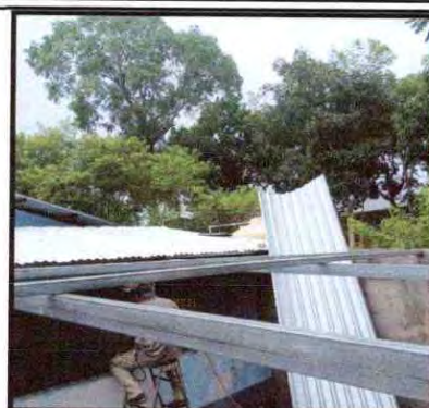
Foto 2: Sustitución de estructura de soporte de madera por metal en ampliación de cocina
