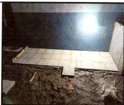
Foto 11: Instalación de piso de granito en ampliación de cocina
