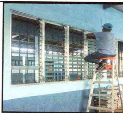
Foto 18: Instalación de ventanería de persiana de aluminio y vidrio en 1 aula
