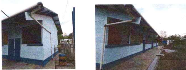
Foto 3: TERMINACION DE INSTALACION DE CANAL
