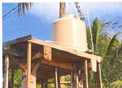
Foto 8: INSTALACION DE ROTOPLAS
