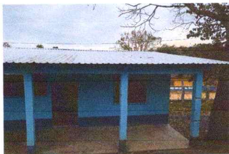
Foto 9: ESTRUCTURA Y LAMINA DIRECCION
