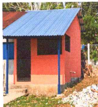
Foto 4: ESTRUCTURA Y LAMINA COCINA
