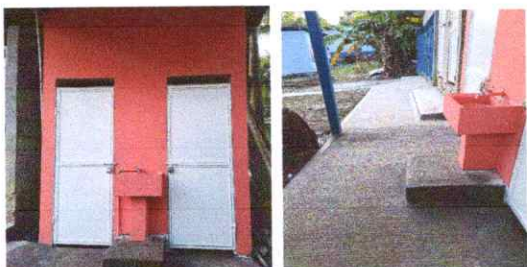
Foto1: BANQUETA, PUERTAS Y PINTURA DE BAÑOS, LAVAMANOS Y GRIFO
