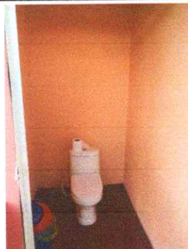
Foto 2: INSTALACION DE BAÑOS Y PINTURA
