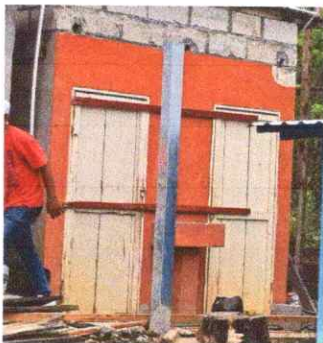
Foto 1: PUERTAS DE BAÑOS
