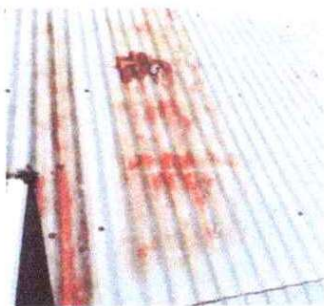
Foto1:Sustitucion de lámina, por lámina troquelada aluzinc calibre 26
