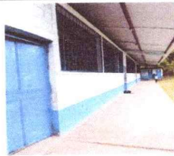
Foto 6: Mantenimiento a balcones de metal
