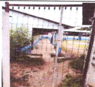
Foto 11: Mantenimiento a porton de metal
