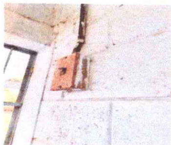
Foto 9: Sustitución de tablero de filpones
