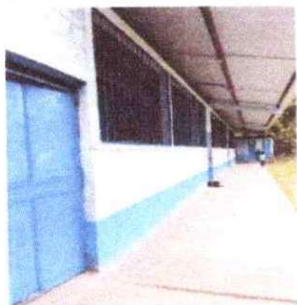
Foto 3:Mantenimiento a estructura de puerta (lijado, cepillado,aplición de pintura )
