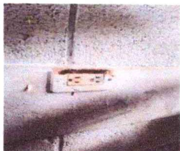
Foto13: Sustrución de tomacorrientes dobles
