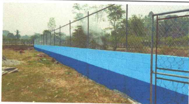
Foto 3: Sustitución de malla por muro perimetral.
