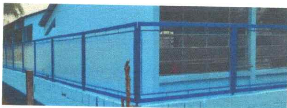
Foto1: Sustitución de malla por balcon con malla.
