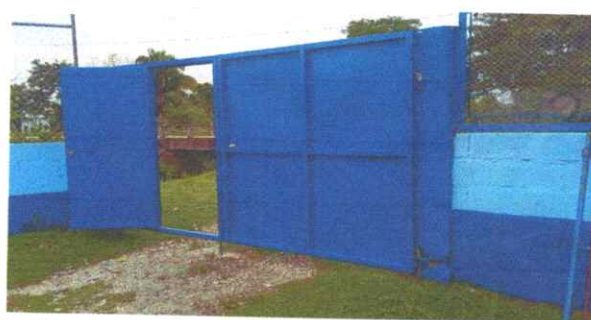
Foto 4: Sustitución de porton.
