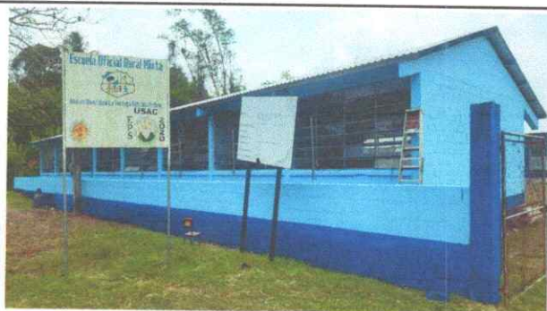
Foto 3: Sustitución de malla por muro perimetral.
