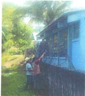
Foto 1: Sustitución de malla por balcon con malla.
