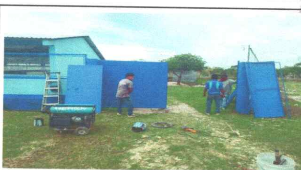
Foto 4: Sustitución de porton.
