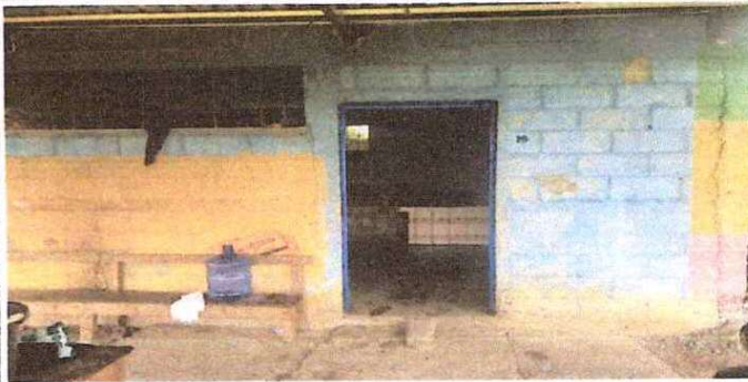
Foto 2. SUSTITUCION DE PISO DE TORTA DE CONCRETO
