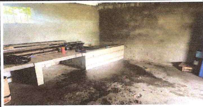
Foto 1: SUSTITUCIÓN DE AZULEJO EN COCINA.
