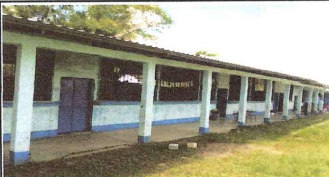
Foto 4: PINTURA EN MUROS EXTERIORES E INTERIORES
