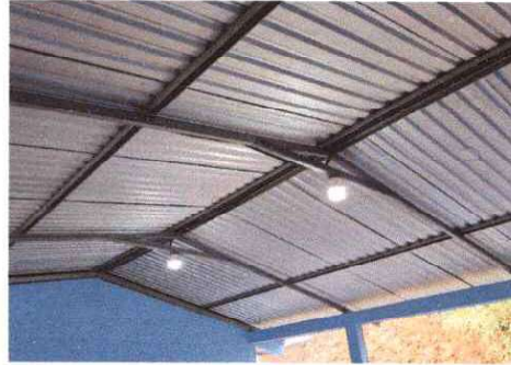
Foto 2: Sustitución de ducto eléctrico mas accesorios
