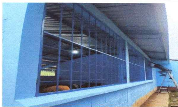
Foto 2: Mantenimiento de balcones de metal.
