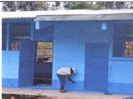
Foto1: Sustitución de puertas.
