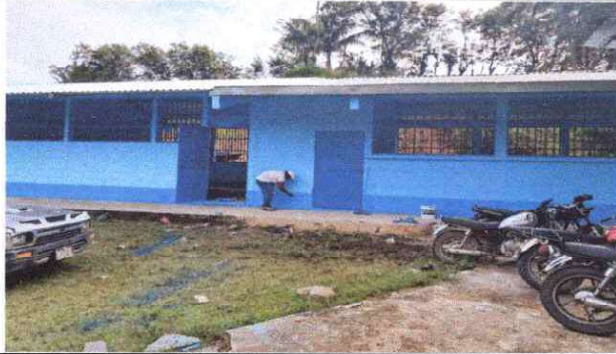
Foto1: Pintura en muros interiores y exteriores.
