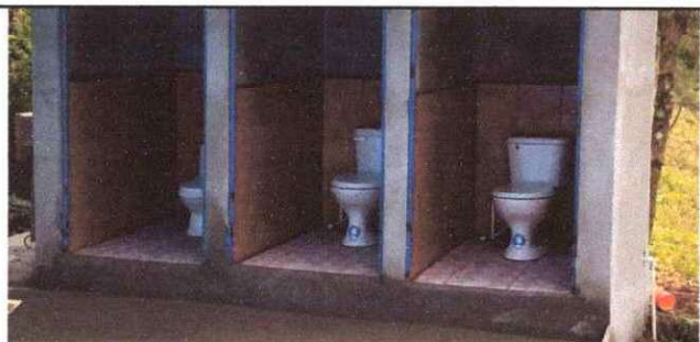
Foto 5: Sustitución de inodoros y accesorios.
