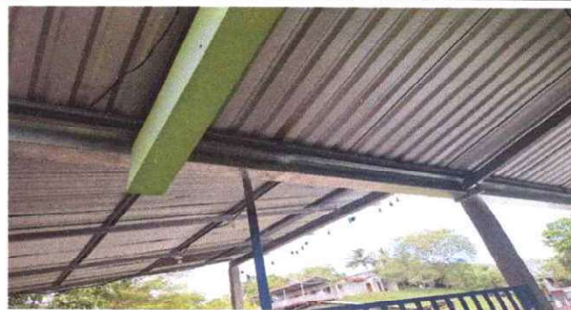
Foto 4: Sustitución de canal de metal.
