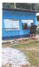
Foto 5: Sustitución de balcones de metal
