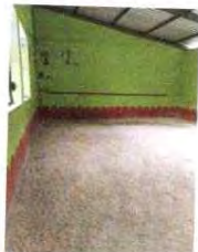
Foto 19: Sustitución de piso, ceramico
