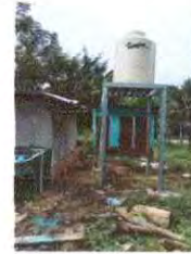
Foto 8: Sustrución de depósito de agua 1100lt
