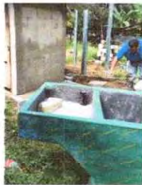
Foto 9: Sustrución de pila de cemento de dos lavaderos
