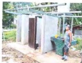
Foto 1: Sustitución de lamina
