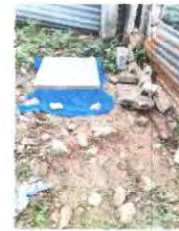
Foto 12: Sustrución de Caja de Registro
