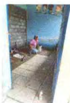
Foto 17: Sustitución de piso, ceramico
