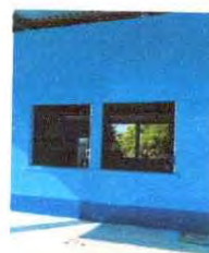
Foto 4: Sustitución de balcones de metal
