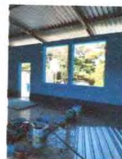
Foto 6: Sustitución de balcones de metal
