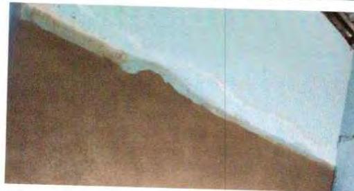
Foto 20: Sellado de giretas y fisuras en muros
