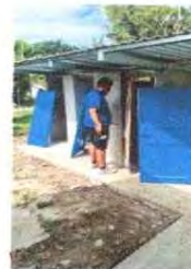
Foto 2: Fabricacion e instalación de puertas de metal en baños
