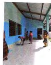
Foto 22: Pintura de muro exteriores e interiores
