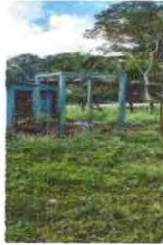
Foto 7: Sustrución de depósito de agua 1100lt
