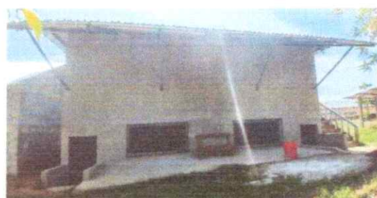
Foto 2: Corredor nuevo, puertas y balcones, piso y repellos de pared.
