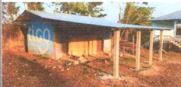
Foto 3: Remozamiento de Cocina finalizado
