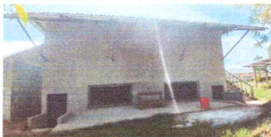
Foto1: Trabajo de reozamiento finalizado en modulo
