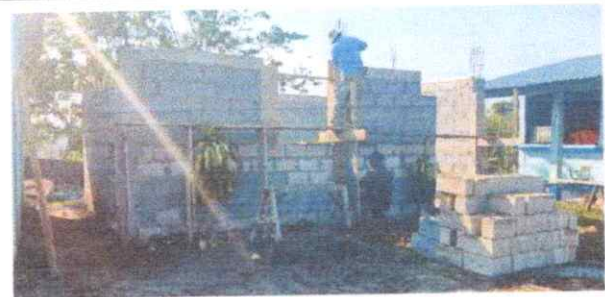
Foto 6: Contrucción de nuevas paredes
