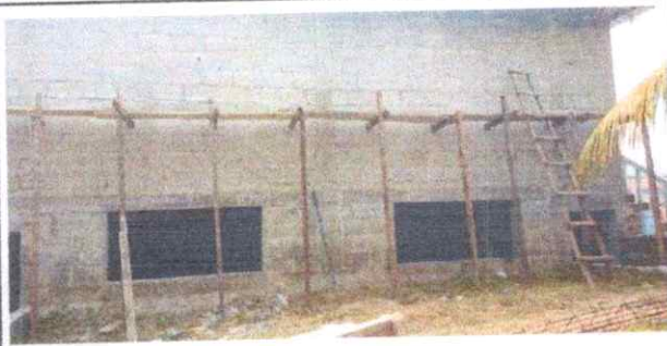
Foto 1: Inicio de trabajo de repello de modulo
