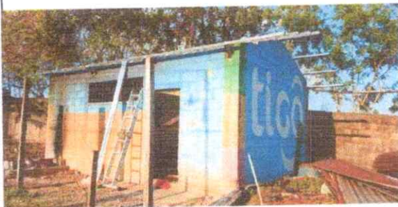
Foto 3: Se inicia labores de Remozamiento de cocina
