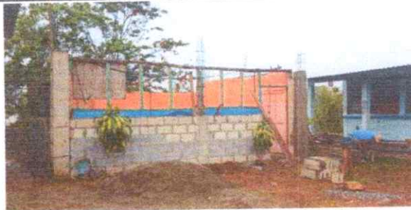
Foto 5: Inicio de labor para remozamiento, modulo de Direccion
