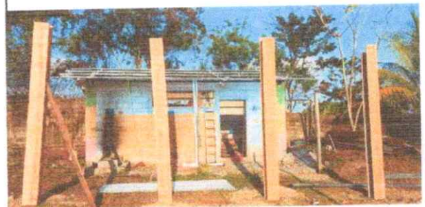
Foto 4: Construcción de columna de concreto
