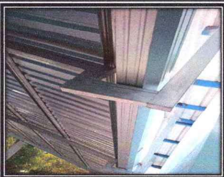
Foto 5: INSTALACION DE CANAL
