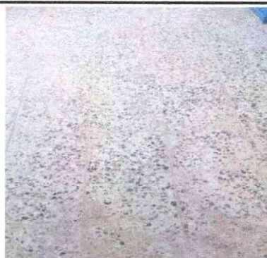
Foto 14: INSTALACION PISO DE GRANITO
