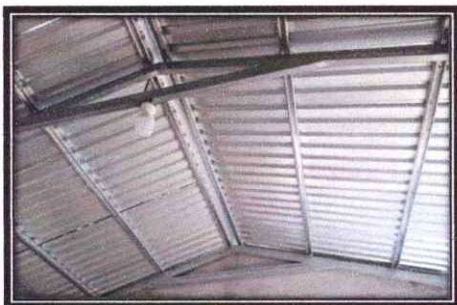
Foto 1 : INSTALACION DE ESTRUCTURA DE SOPORTE DE METAL
