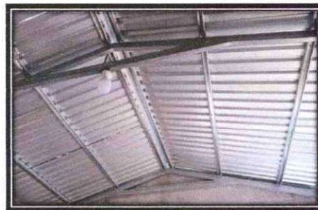
Foto 2: INSTALACION DE LAMINA TROQUELADA ALUCINZ CALIBRE 26
