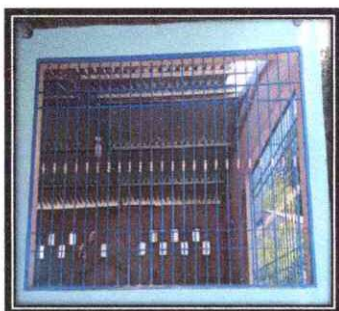
Foto 3: INSTALACION DE BALCON
